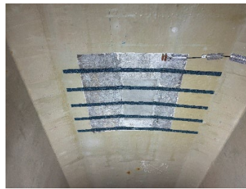
【樹脂・FRP プレート施工後】
