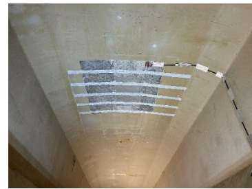
【表面上塗り施工後】
