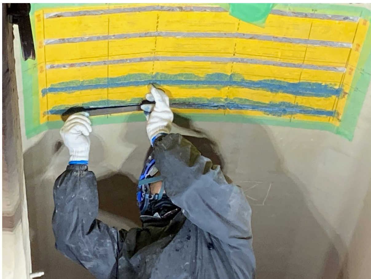
【FRP プレートの埋め込み作業】
